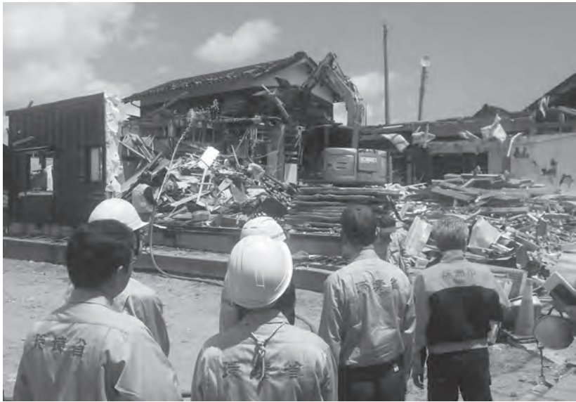
能登半島地震の公費解体は2月末によく完了した（写真提供＝環境省）
